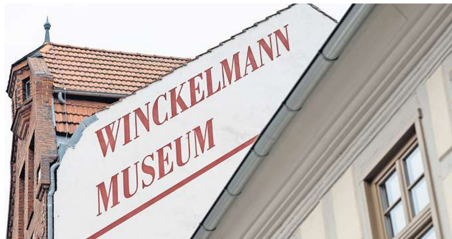
Fassade des Winckelmann-Museums in Stendal.
